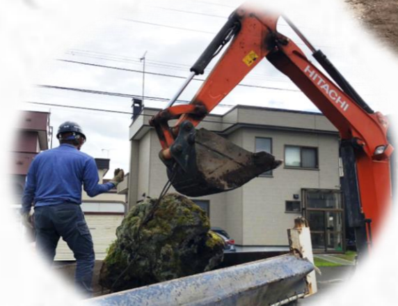
既存天然石撤去処分
