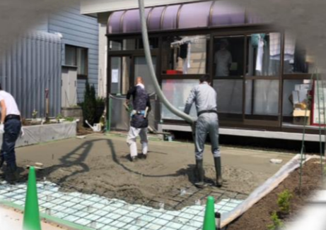
土間コンクリート打設
