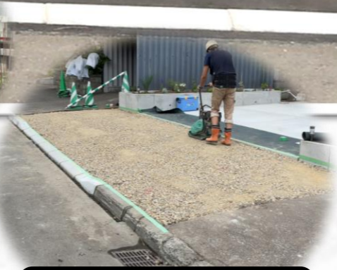
舗装下地、縁石低下施工
