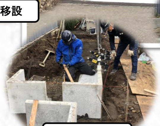
L型ブロック設置
