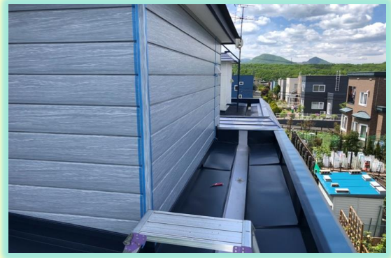
裏下屋根 施工完了状況詳細
